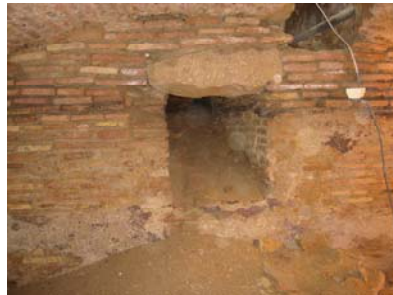
017 UE 204 interior paret nord.JPG
