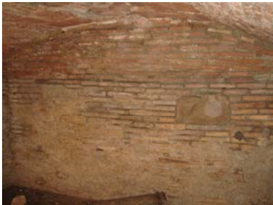
016 UE 204 interior paret sud.JPG
