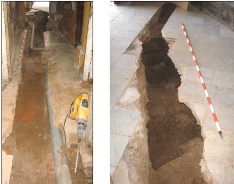
Vistes generals finals de la Rasa, a l'esquerra en sentit sud el primer tram i a la dreta en sentit sud el segon tram. Els treballs arqueològics es van aturar a la cota de 0.70m, profunditat que necessitaven per col·locar les noves canalitzacions
