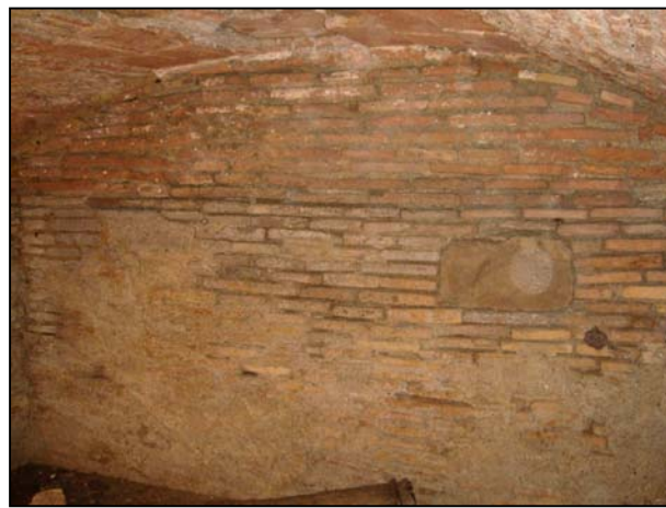
A l'esquerra detall interior de la paret nord del pou UE 204 en el que es pot comprovar com desguassarien aigües mitjançant una canalització. A la dreta detall interior de la paret sud i de part de la volta
